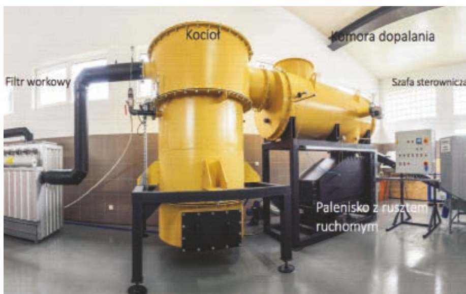
Budowa linii do utylizacji osadów ściekowych z odzyskiem energii cieplnej
